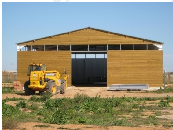
Imagen 8: Nave de mecanización agraria en Agrópolis
