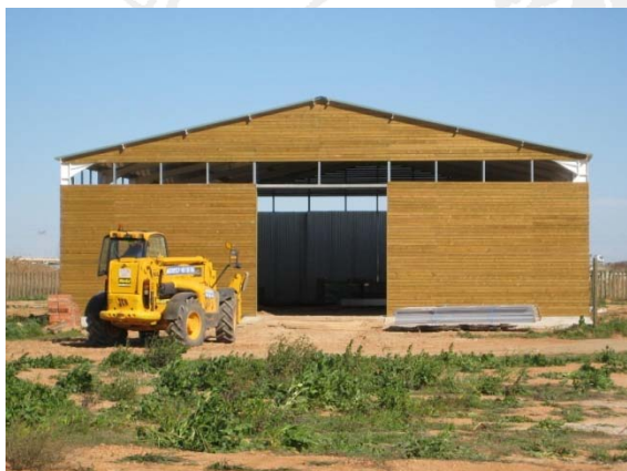
Imagen 9: Nave de mecanización agraria en Agrópolis
